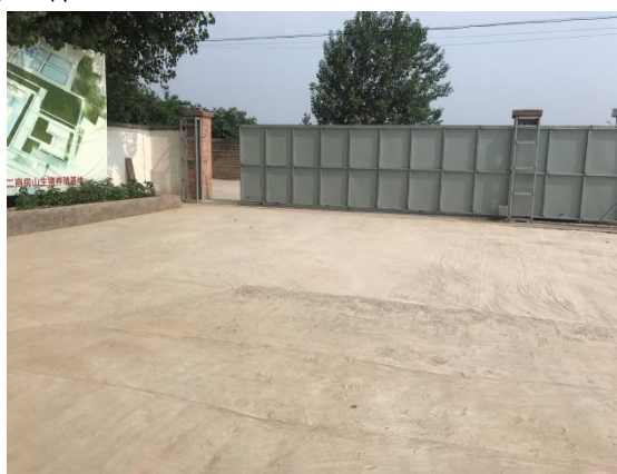
施工临建区场地硬化
