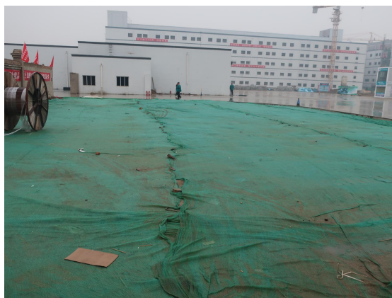
室外工程区临时覆盖
